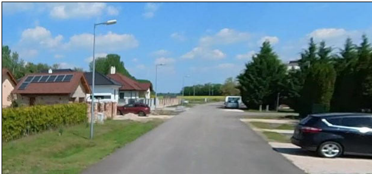
Öttevény, Orgona utca, a közvilágítást a beépítésre szánt terület határáig már megvalósították /Forrás: KIRA Street View/
