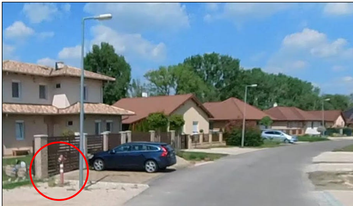
Öttevény, Orgona utca, meglévő felszín feletti tűzcsap
